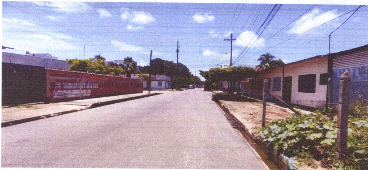
VISTA DE LA CALLE 18 EN DIRECCIÓN A LA CARRERA 26
